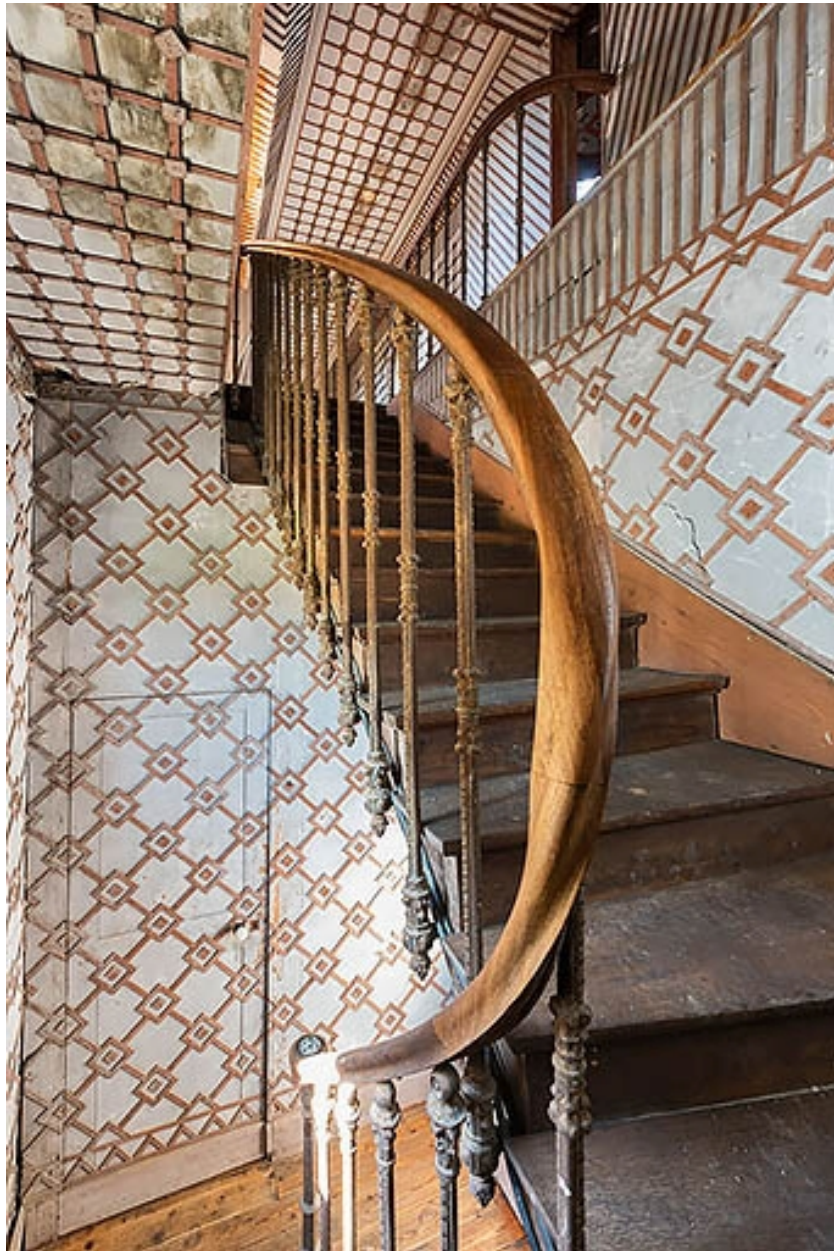
Corps nord (théâtre) : escalier d'accès au balcon.
