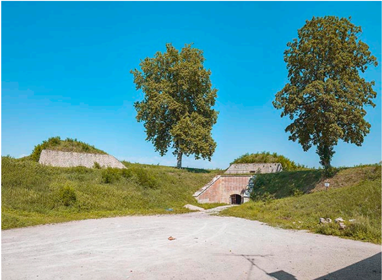
Vue générale du bastion depuis sa gorge.
