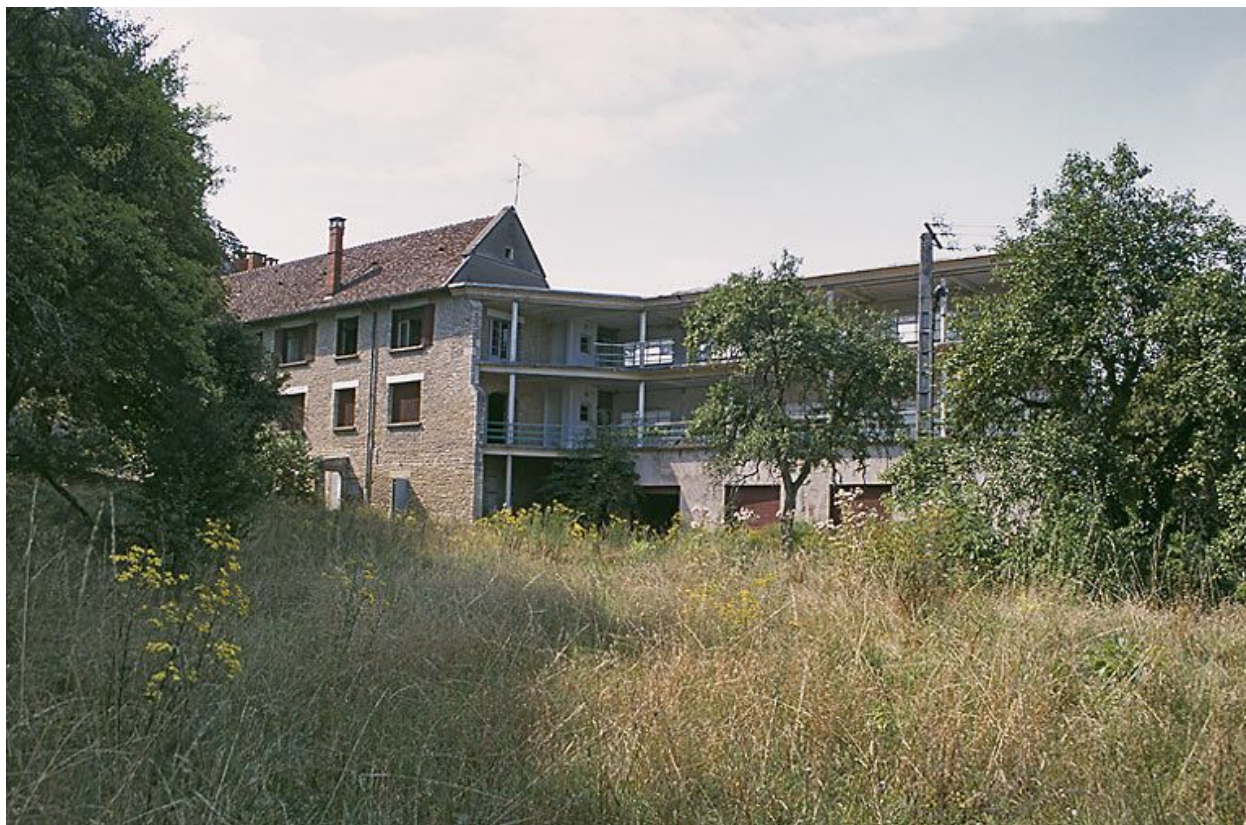
Galerie de cure est, façade sud-est.
