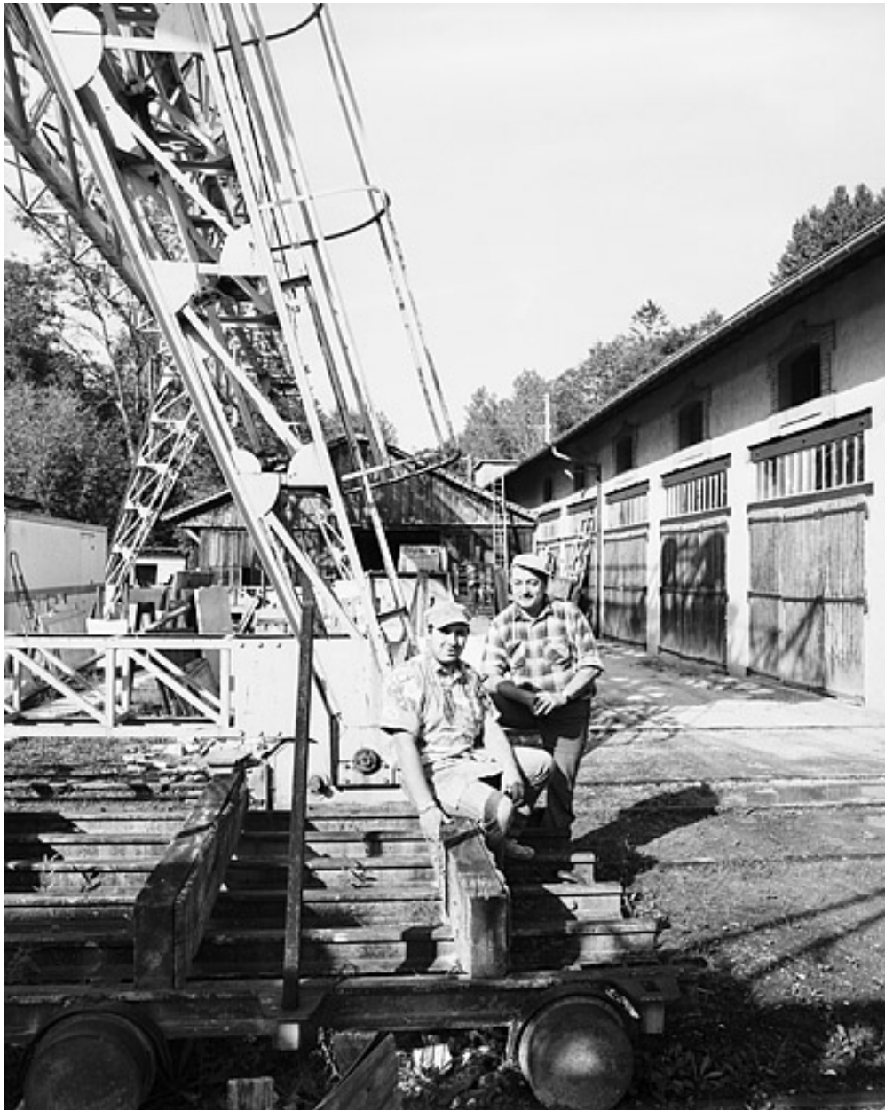
Ouvriers au pied du portique roulant.
