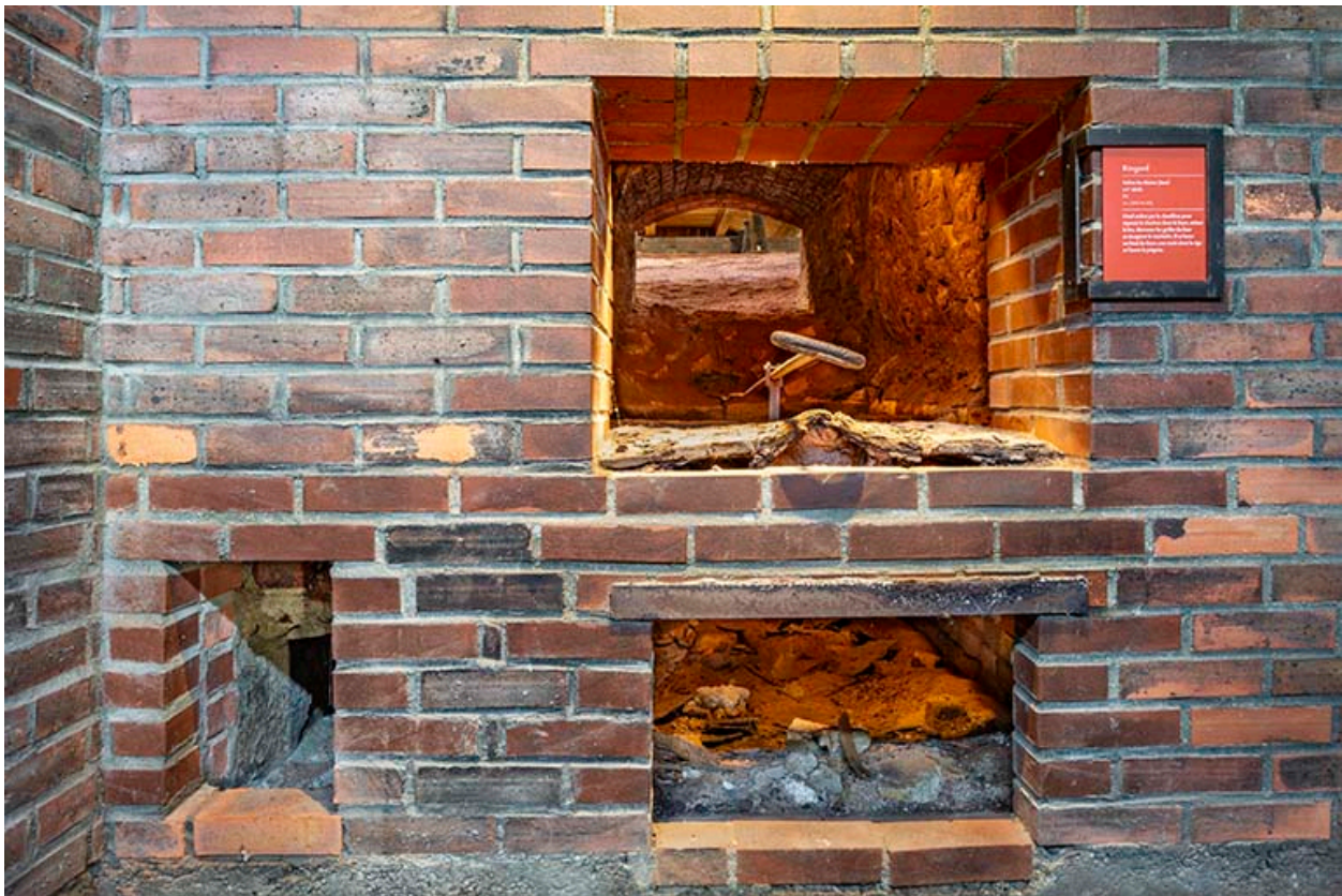
Reconstitution des ouvertures (chargement, tirage et cendrier) au rez-de-chaussée de la salle des poêles.
