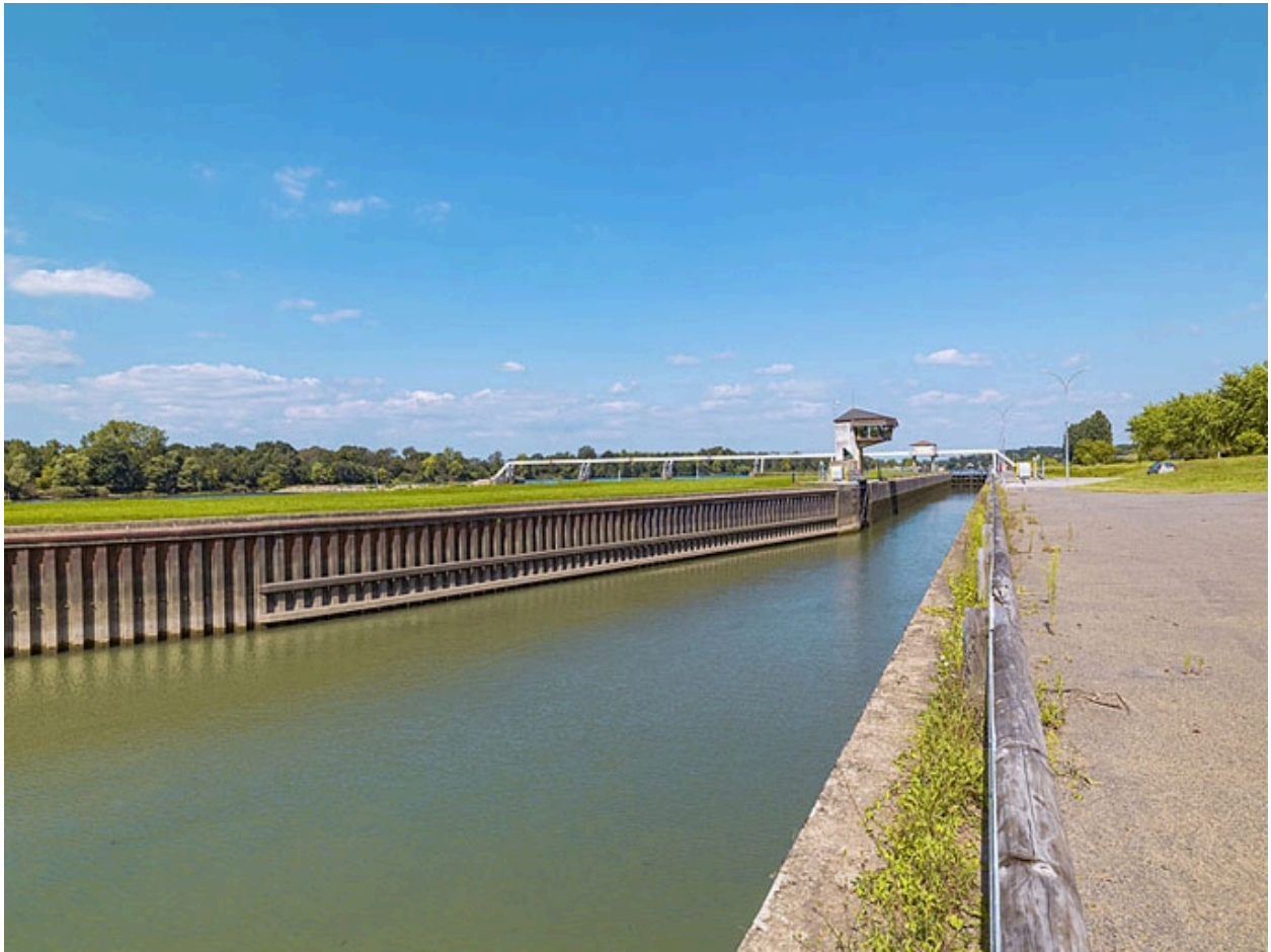
Le sas vu d'aval.
