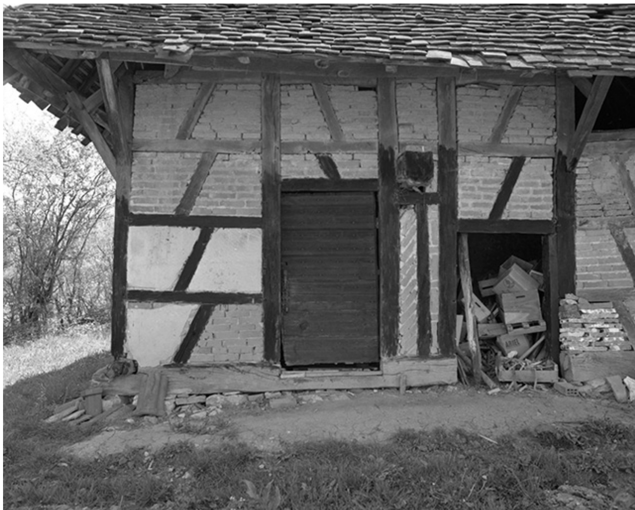
Ferme cadastrée 1969 AL 137 : vue du colombage.
