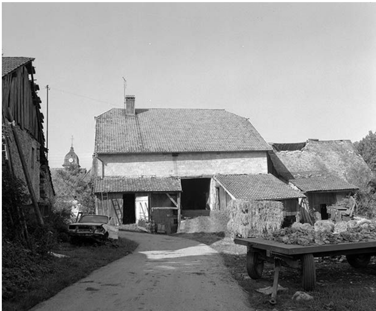
Face latérale : l'entrée de grange.
