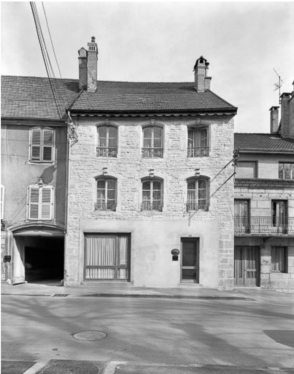
Maison 16 place Gustave Courbet : façade antérieure.
