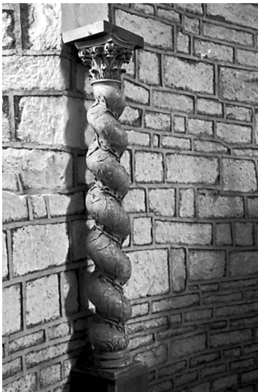
Vue générale d'une colonne.
