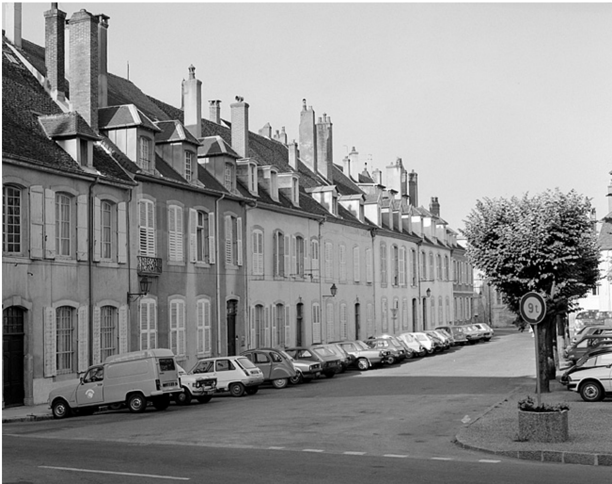
Maisons des chanoinesses. Vue d'ensemble : 1 à 13 place Bichat.
