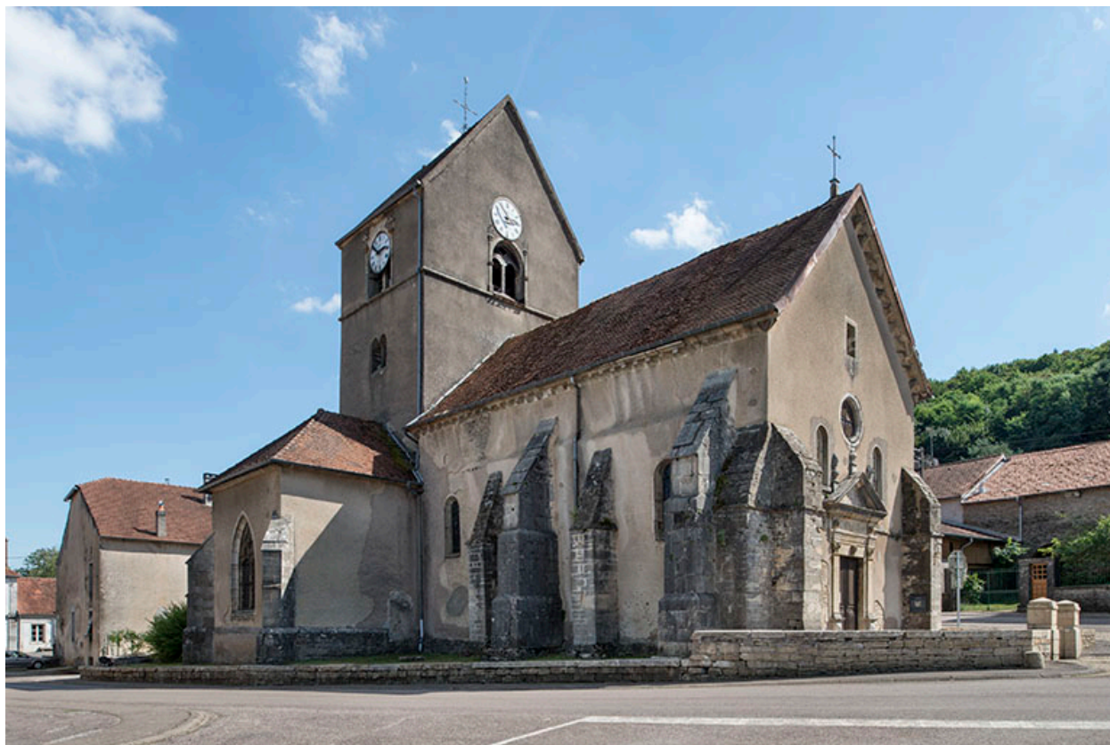
Vue avant restauration (2016).
