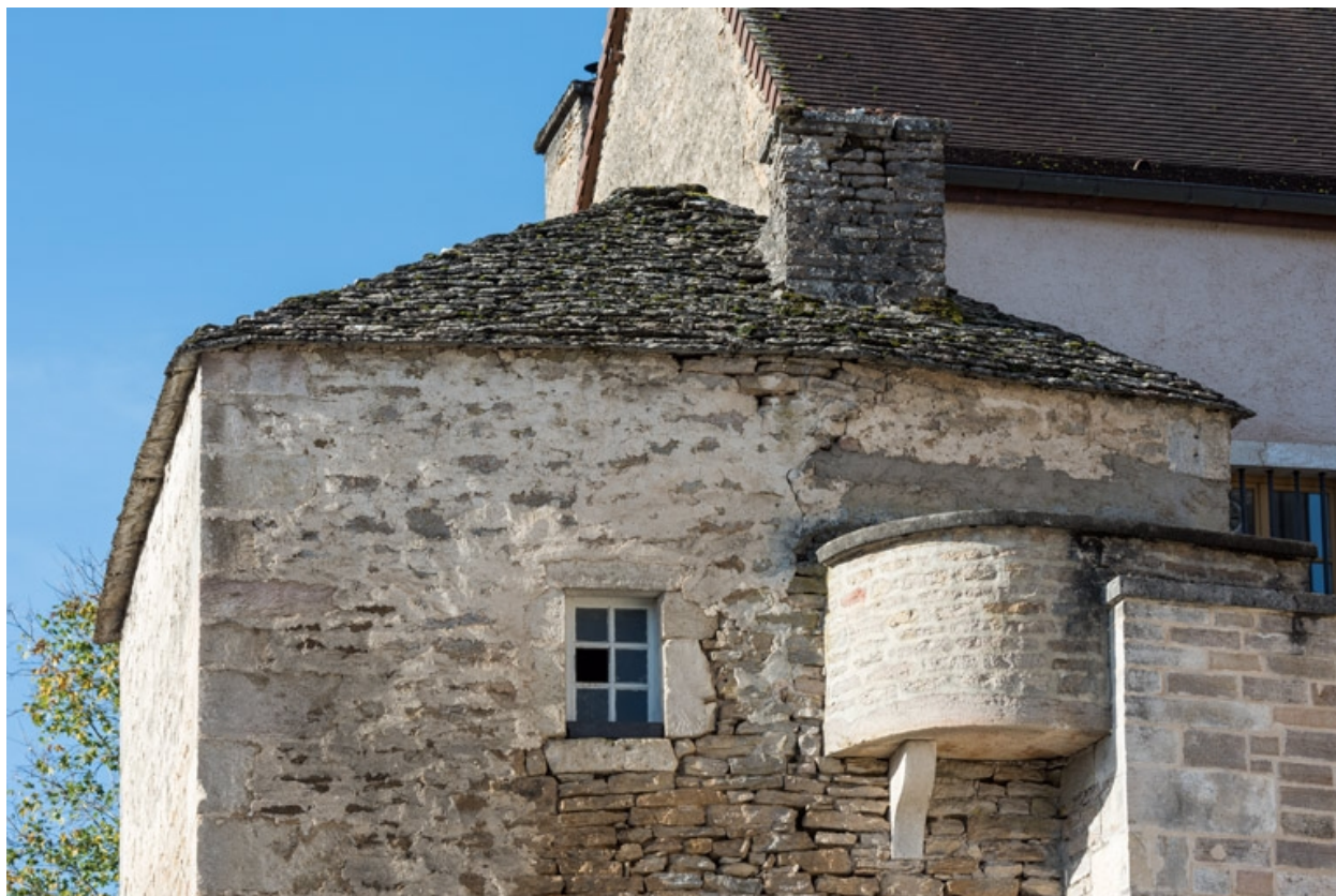
Vue de la toiture depuis l'ouest.
