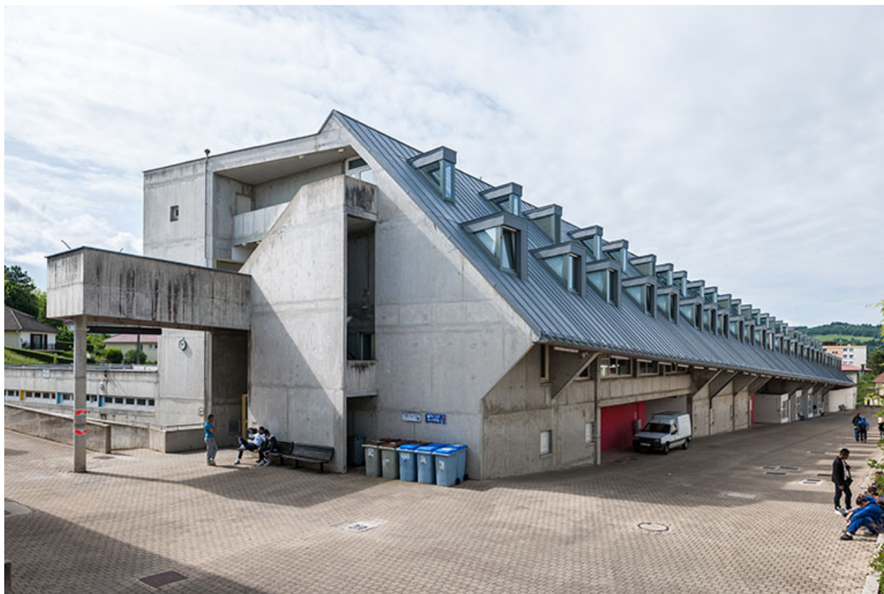
Façades et pignon nord du bâtiment internat-administration.
