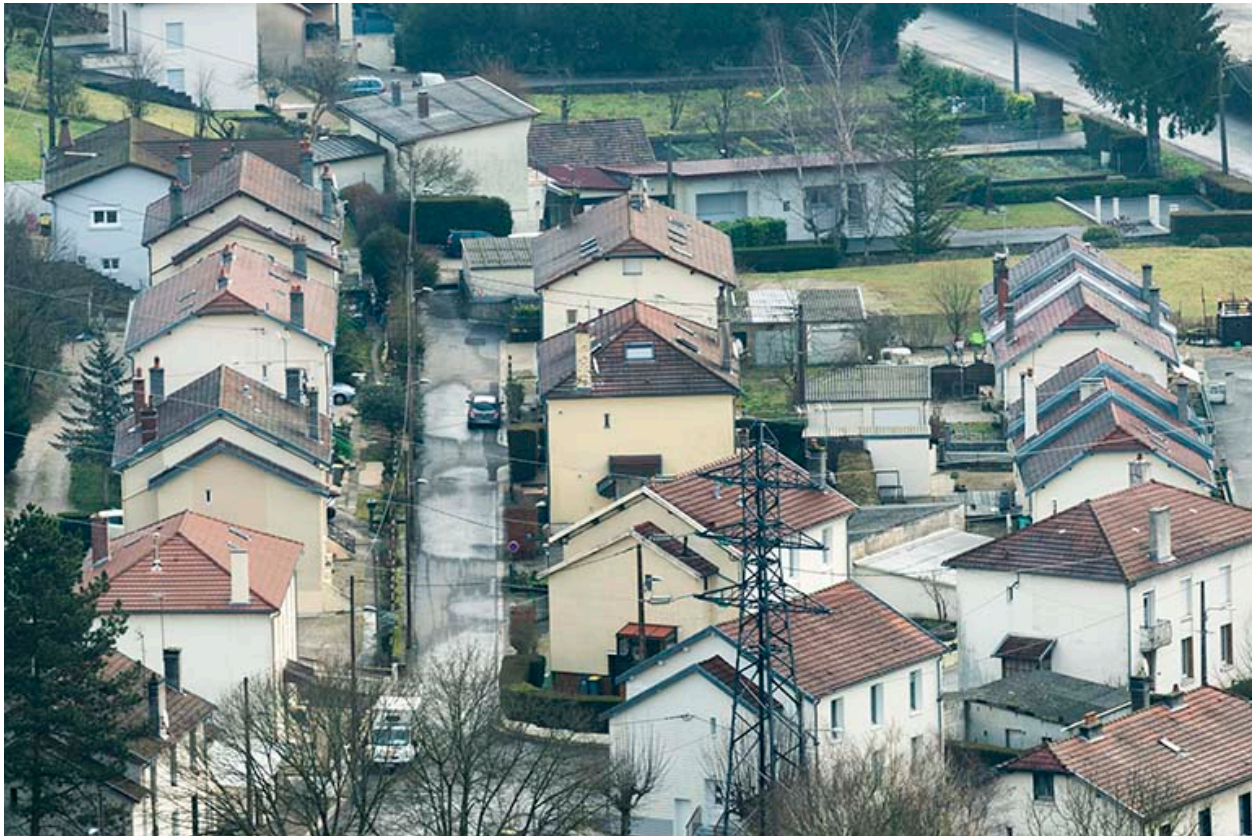
Etat en 2016. Cité ouvrière : vue plongeante, depuis l'ouest.
