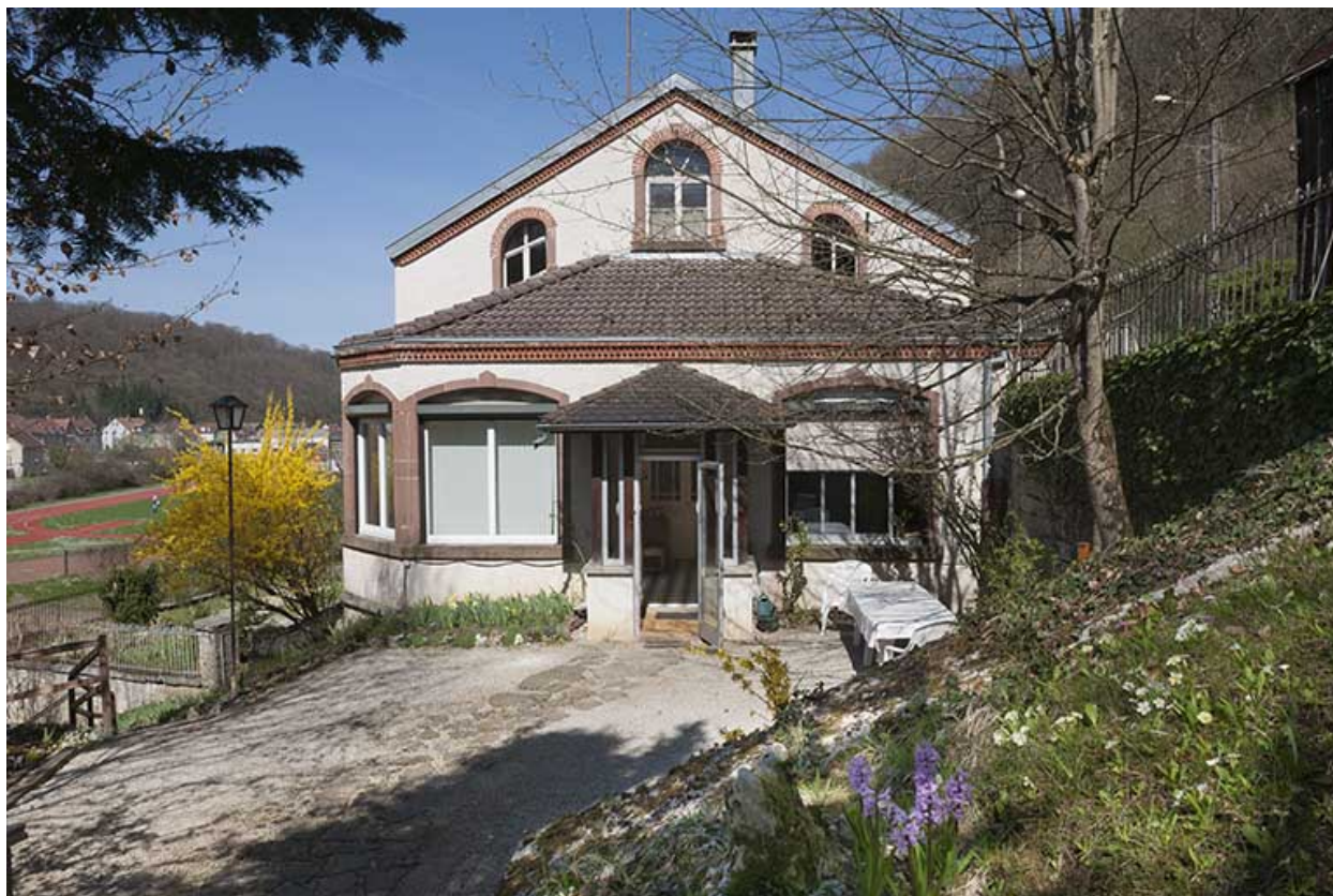
Pignon sud. Entrée.
