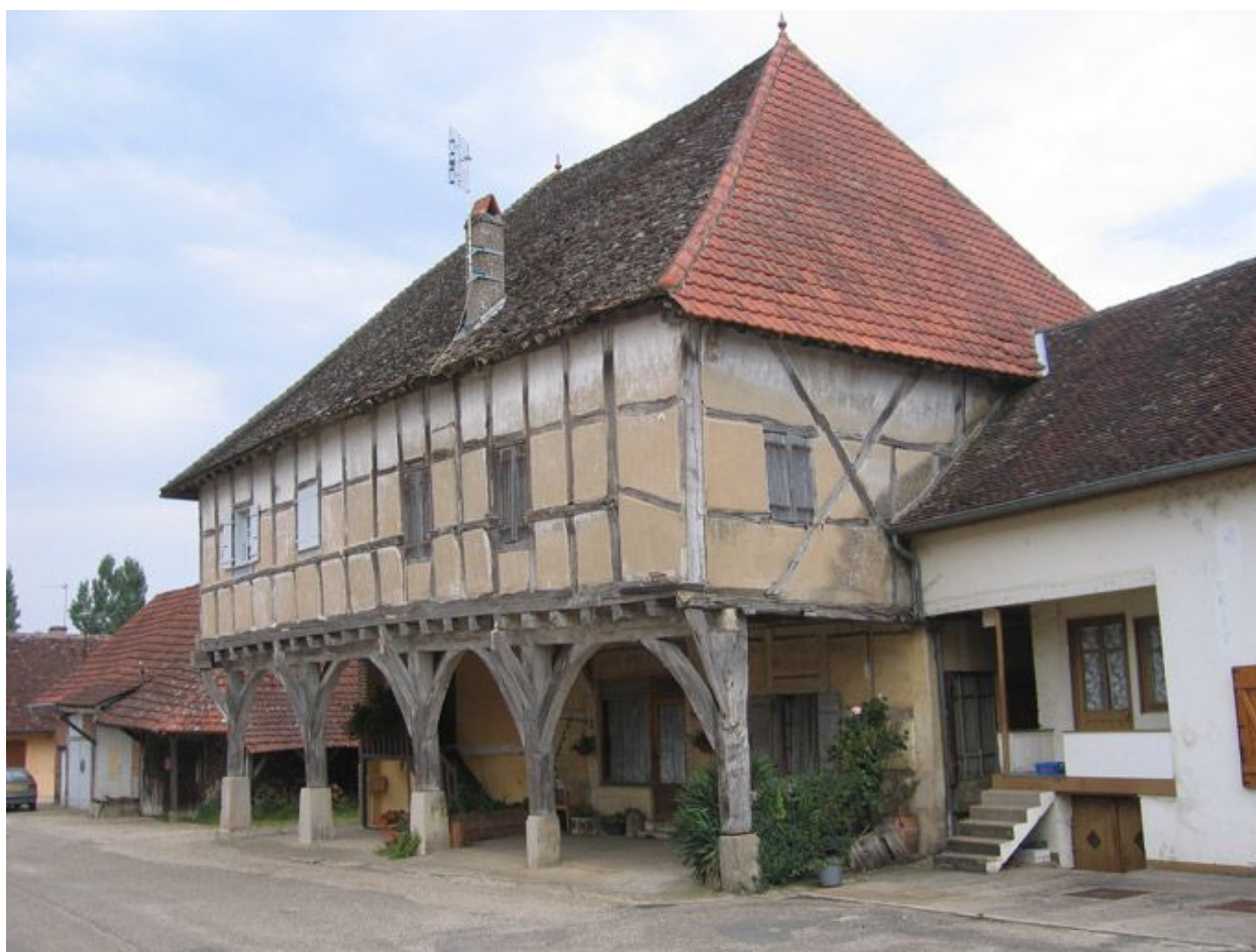
Vue d'ensemble de la façade.
