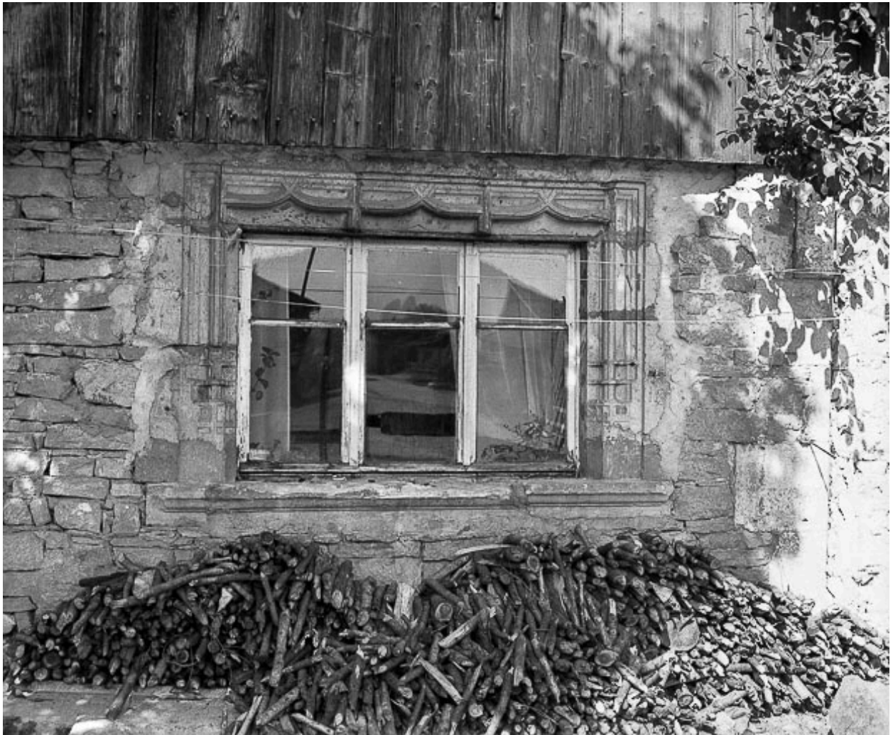
Façade antérieure : fenêtre.
