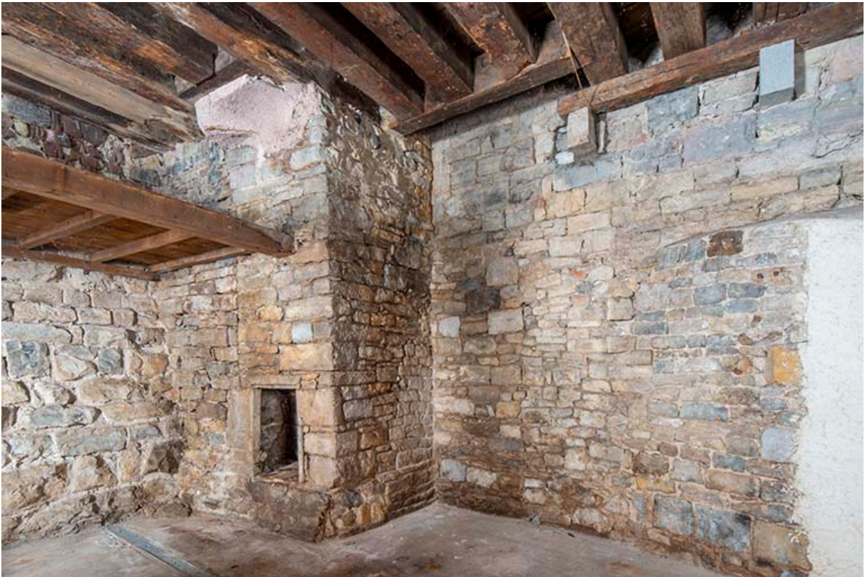
Cave ouest. Maçonneries à l'angle nord-est.
