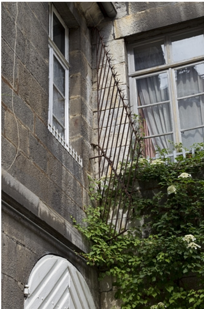
Cour : détail d'une grille de protection.
