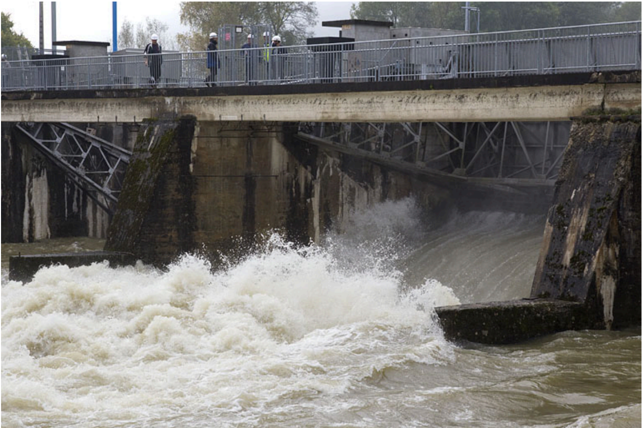
Délestage de la vanne segment centrale.
