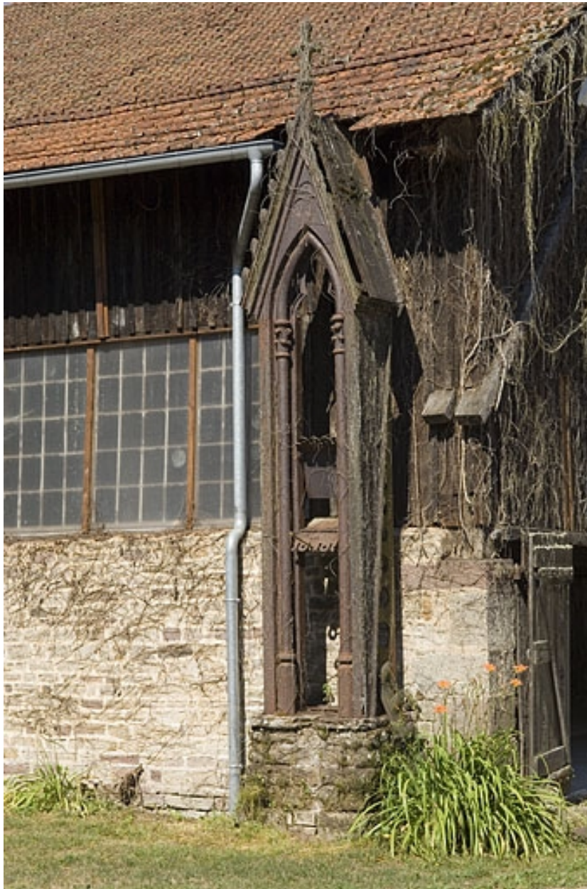
Pinacle en fonte adossé au magasin industriel.
