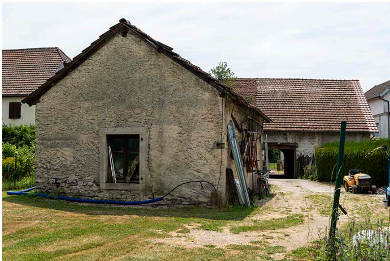
Forge : façade postérieure, de trois quarts droite.
