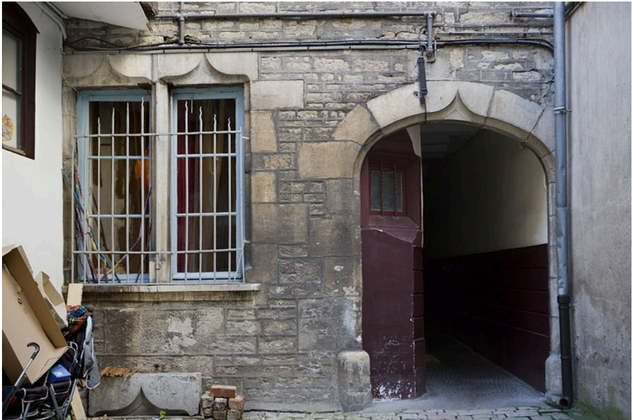
Détail du rez-de-chaussée de la façade postérieure du logis principal.
