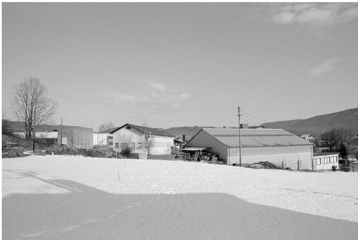
Vue d'ensemble des bâtiments (P, T).
