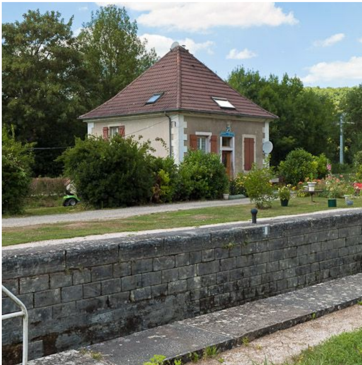
Vue d'ensemble du site d'écluse.
