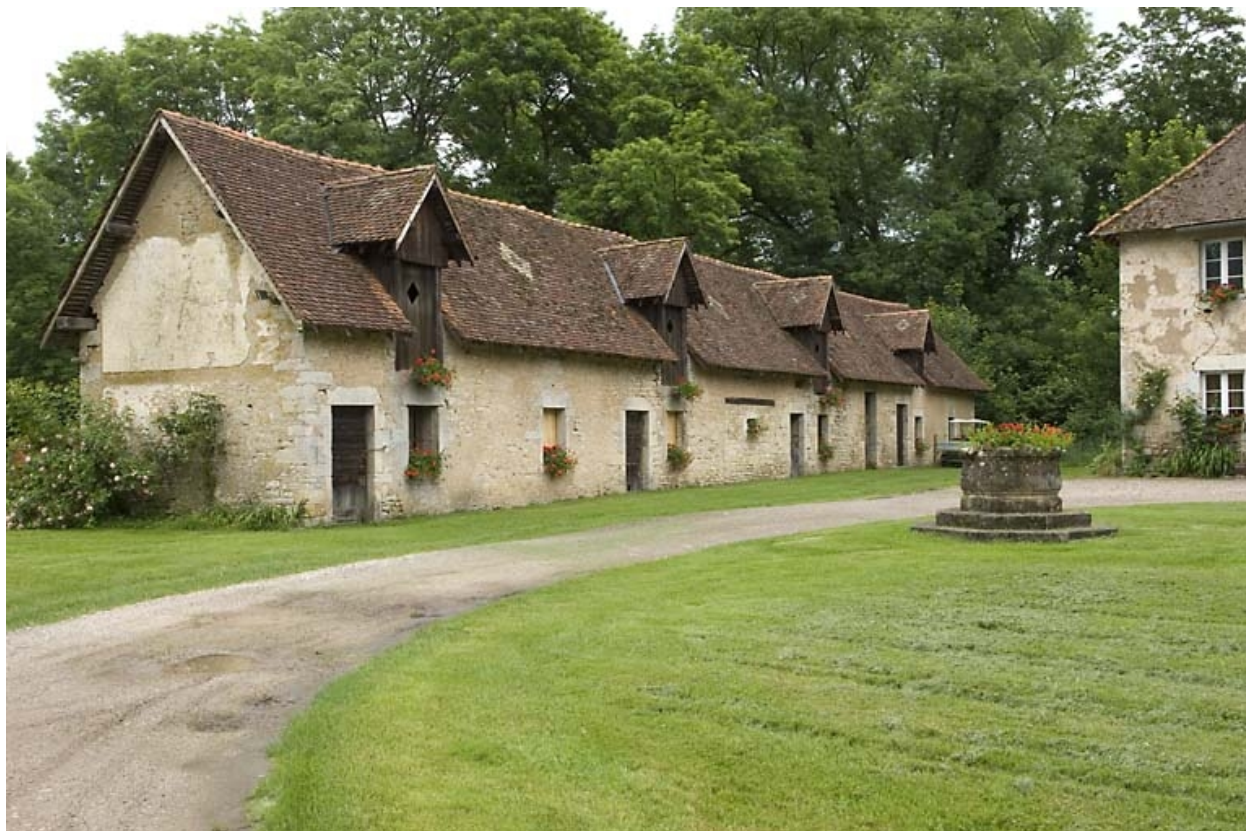
Logement ouvrier vu depuis le nord.
