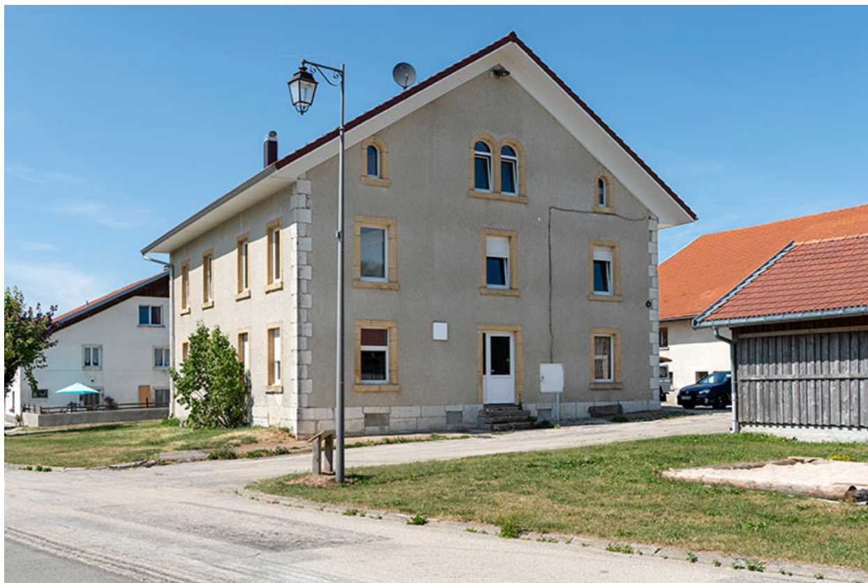
Façades sud et ouest.
