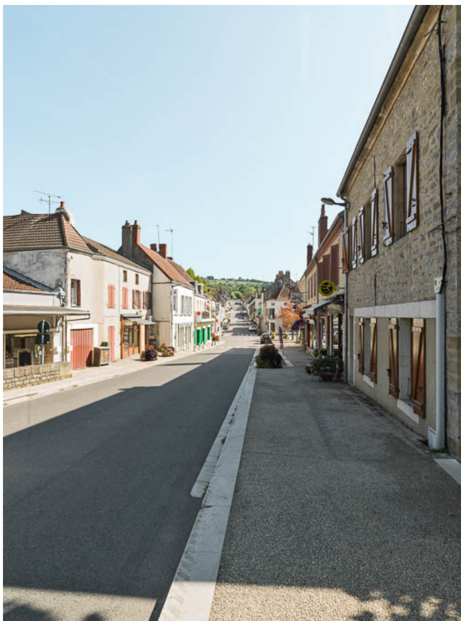
Vue de la rue du pont.
