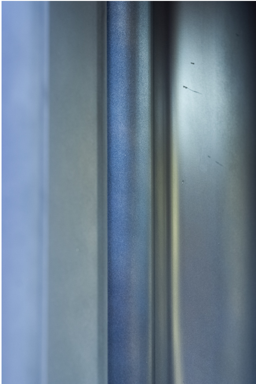
Salle des Assemblées : détail d'un panneau en aluminium anodisé de P. Sabatier.
