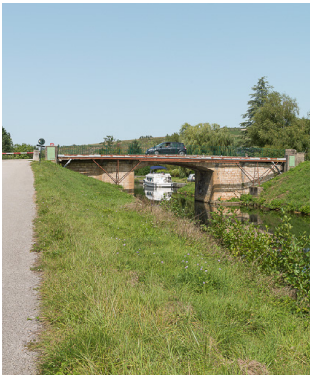
Vue du pont.
