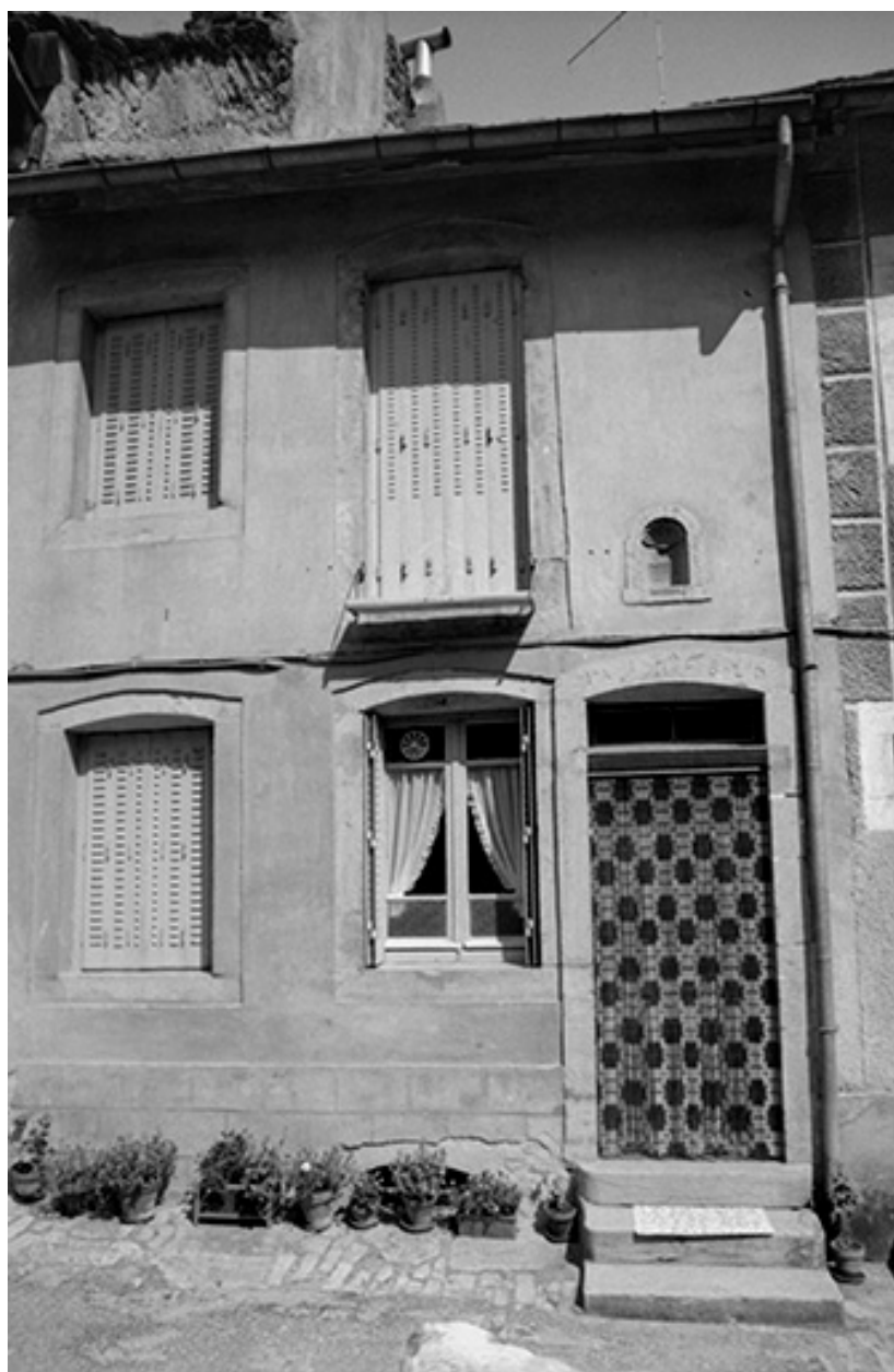
Maison située rue Haute-du-Bourg : façade antérieure.
