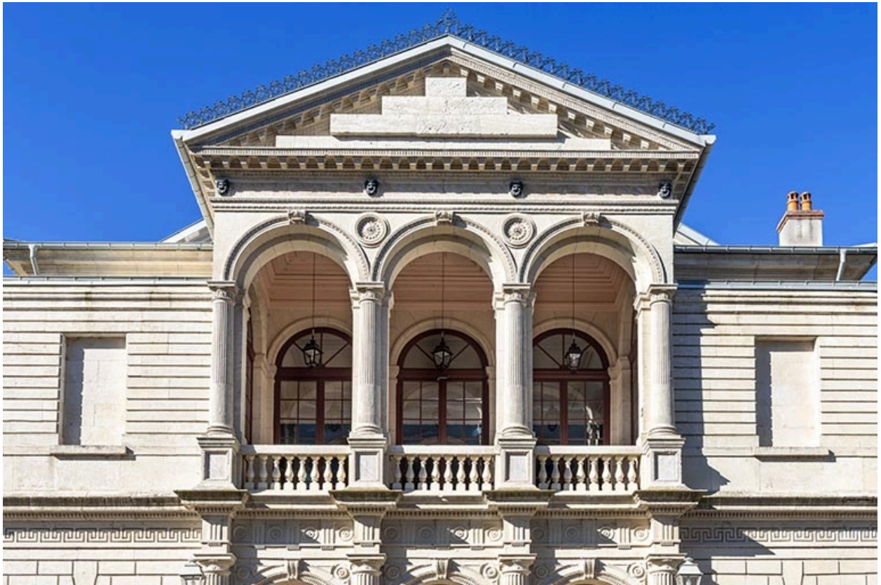
Façade antérieure : loggia, vue en contre-plongée.
