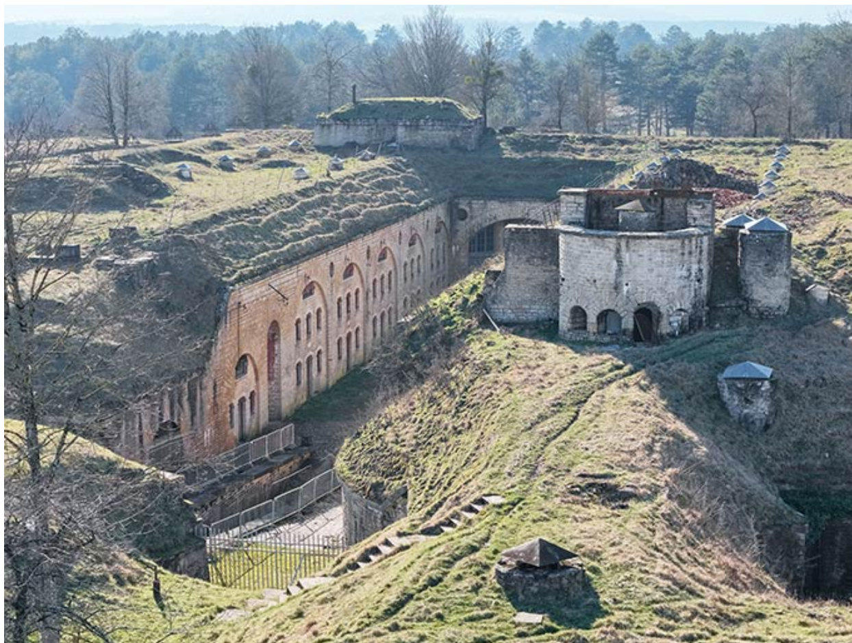
Les casernes (à gauche) et la tour de transmission (à droite), vues de trois quarts. (vue aérienne).
