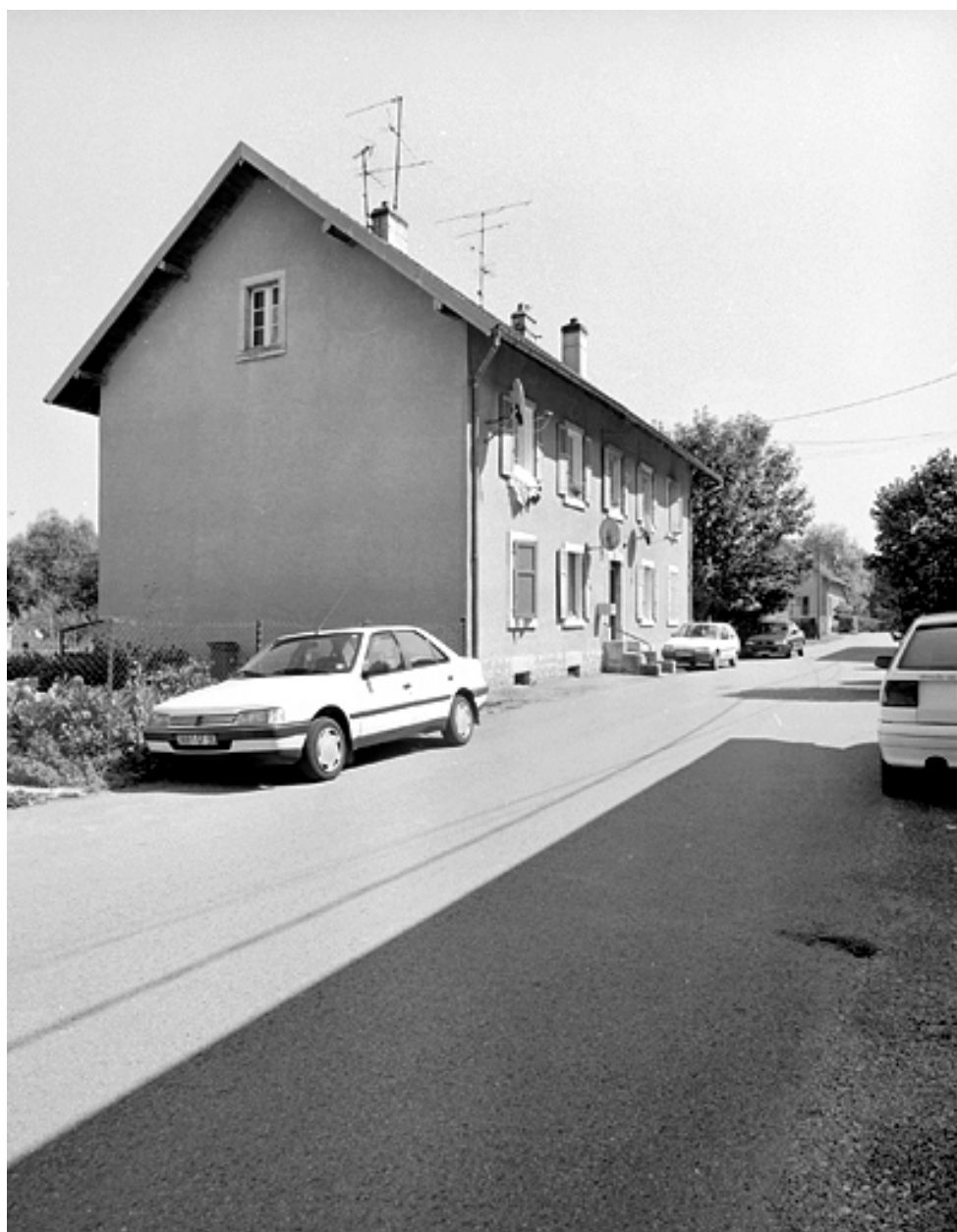
Logement ouvrier à 4 appartements.
