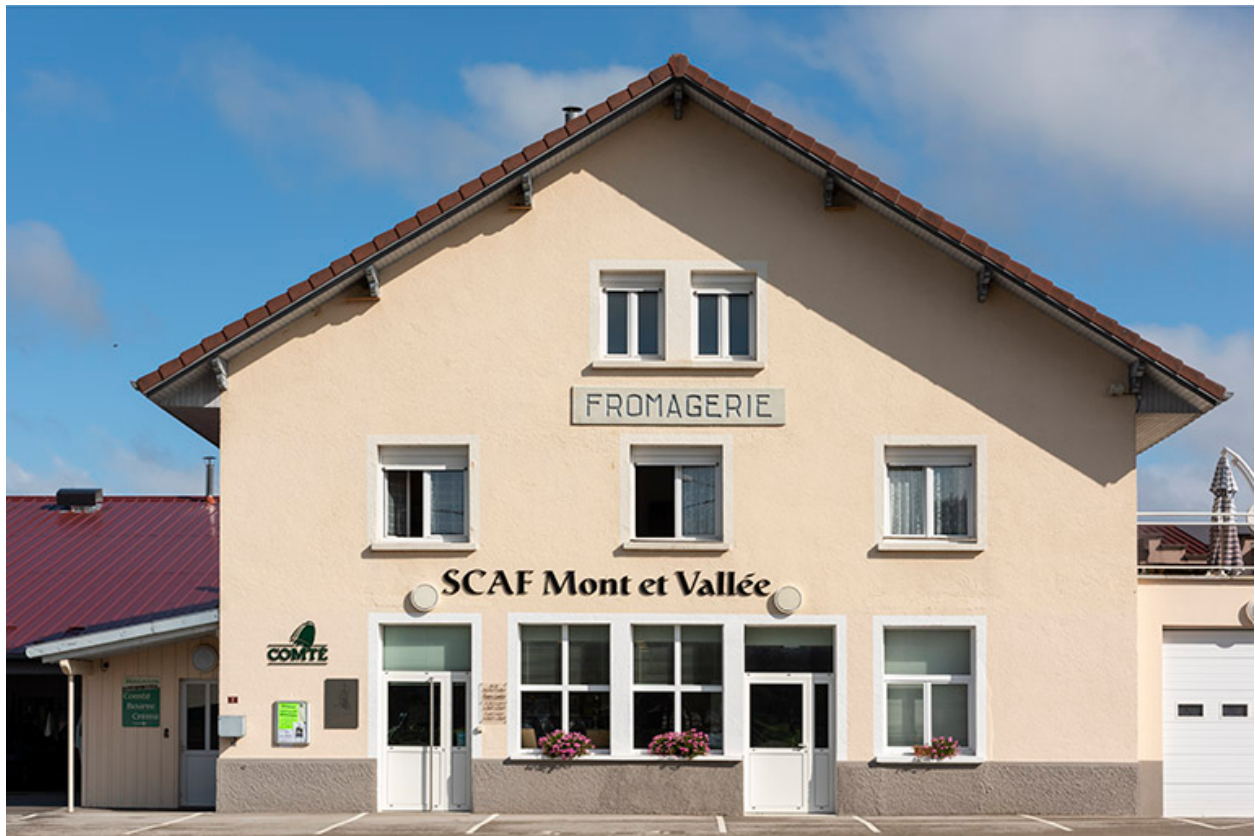
Bâtiment de 1820 : façade antérieure.
