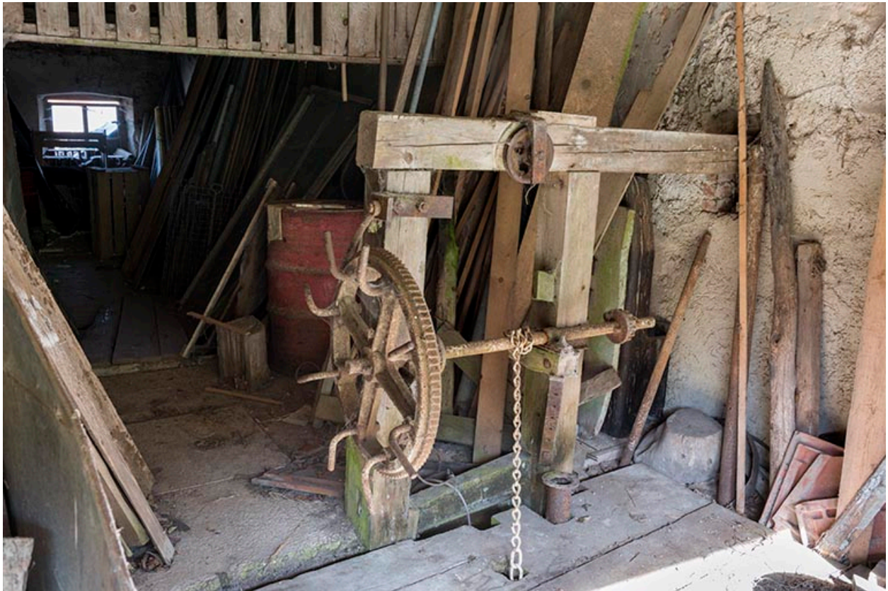
Bâtiment ancien, partie gauche (bâtiment d'eau) : commande de la vanne d'admission d'eau.
