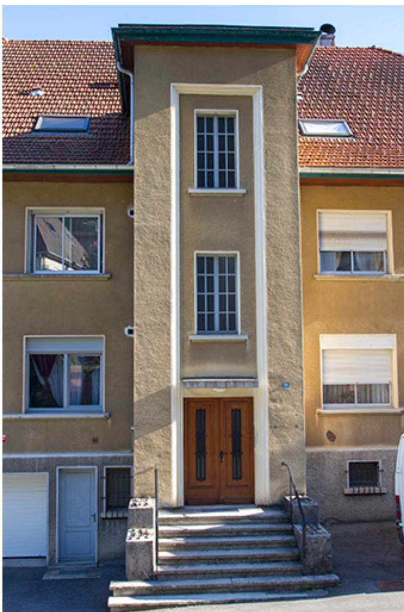
Entrée et cage d'escalier.
