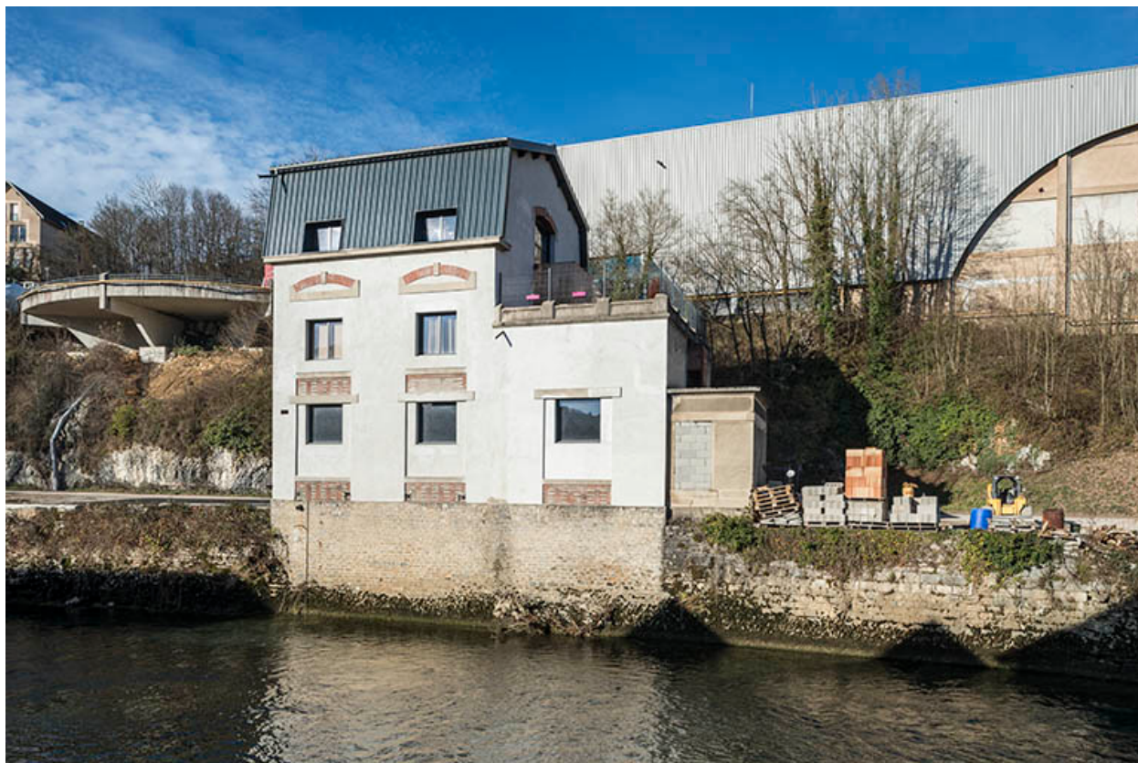
Transformateur. Façade sud.
