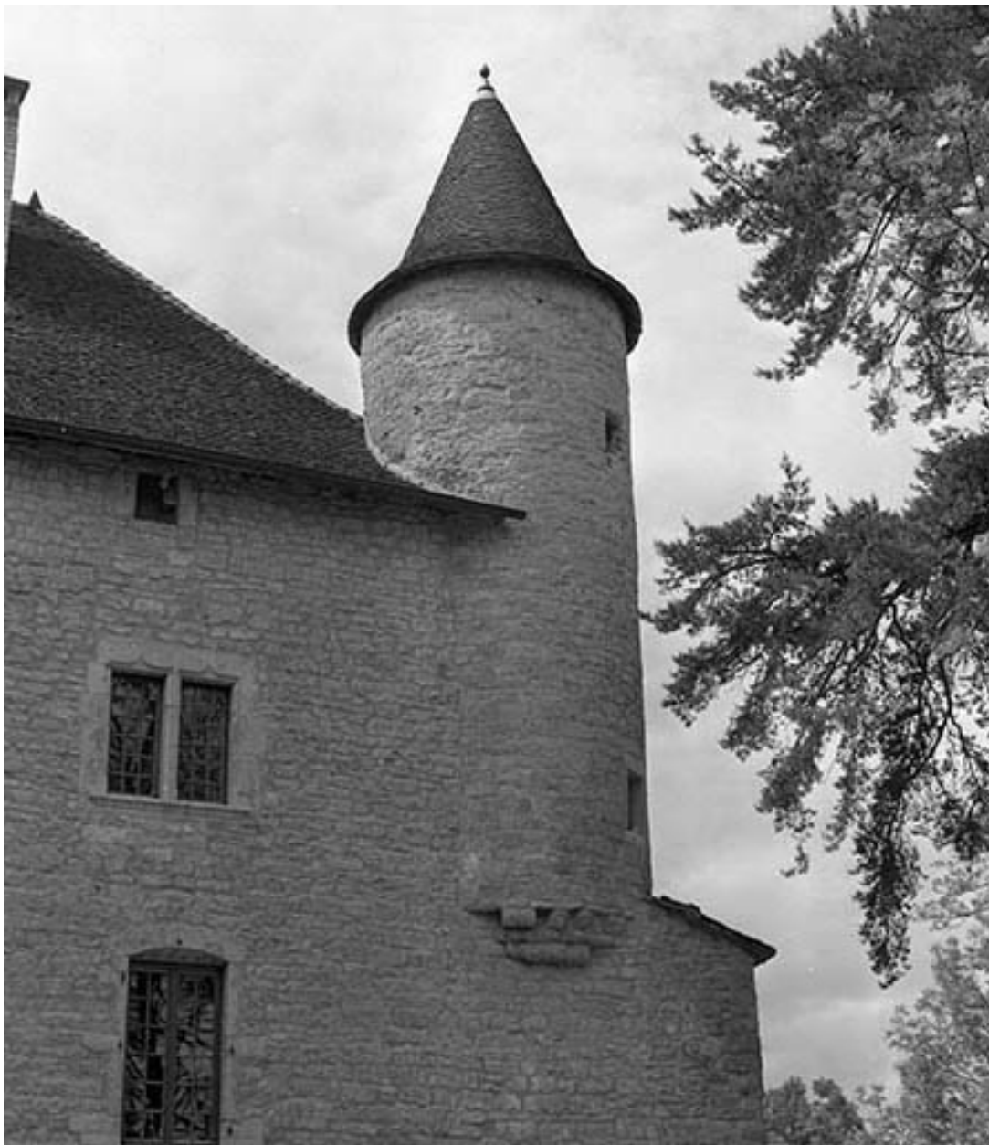
Vue générale de la tourelle de l'angle nord-est
