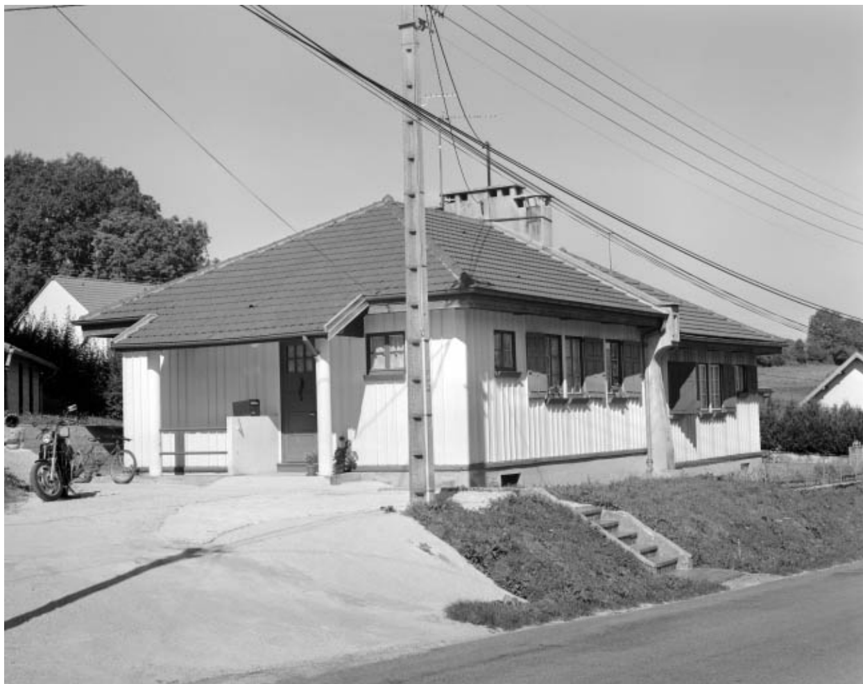
Logement double (maison Fillod).
