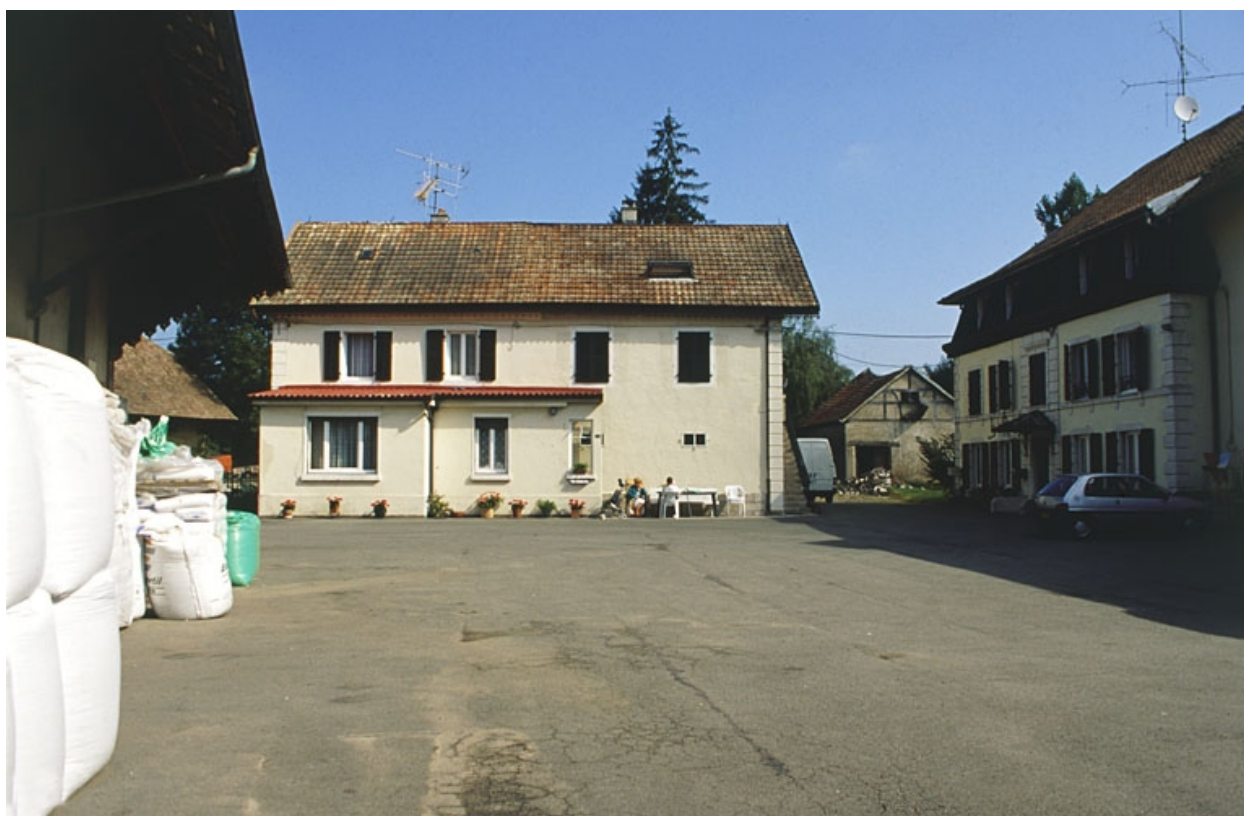
Logements depuis la cour.
