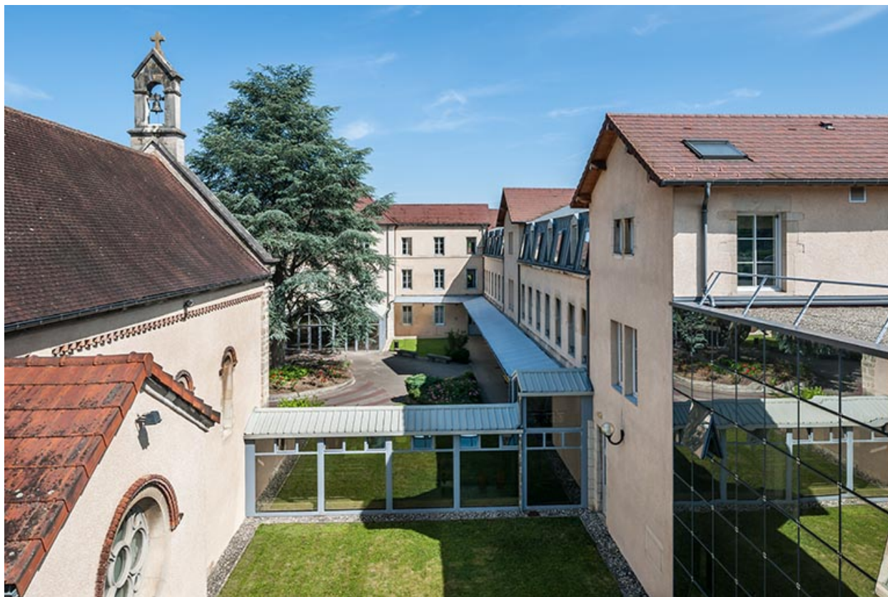
Façades Est sur cour : externat, chapelle.
