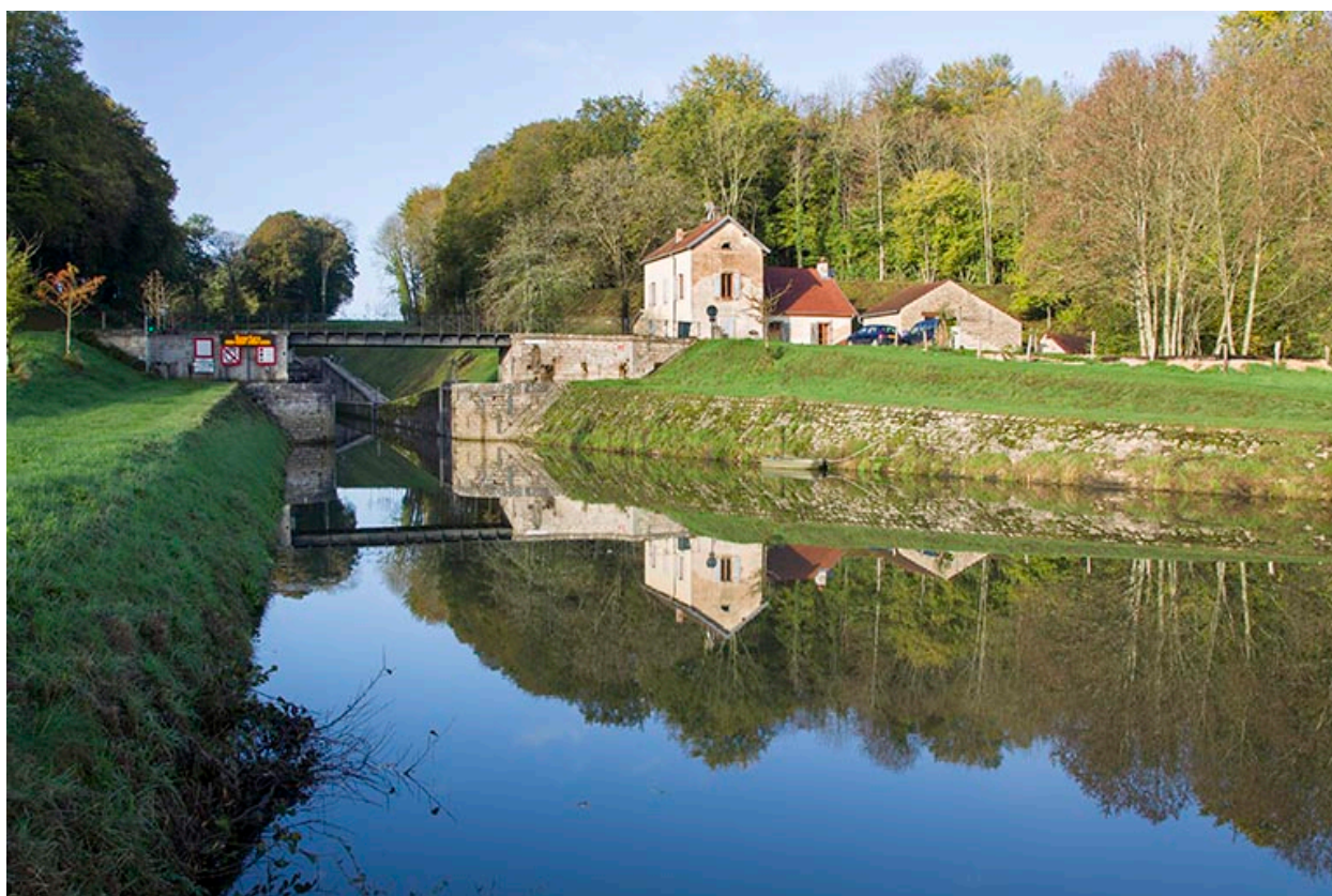
Entrée du canal depuis l'amont.
