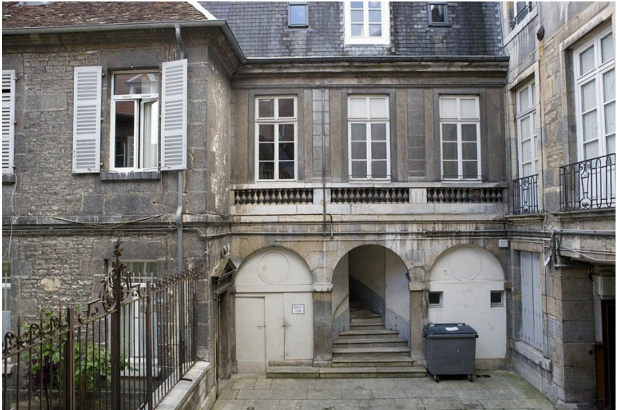
Vue de l'aile à droite de la première cour contenant l'escalier : de face.
