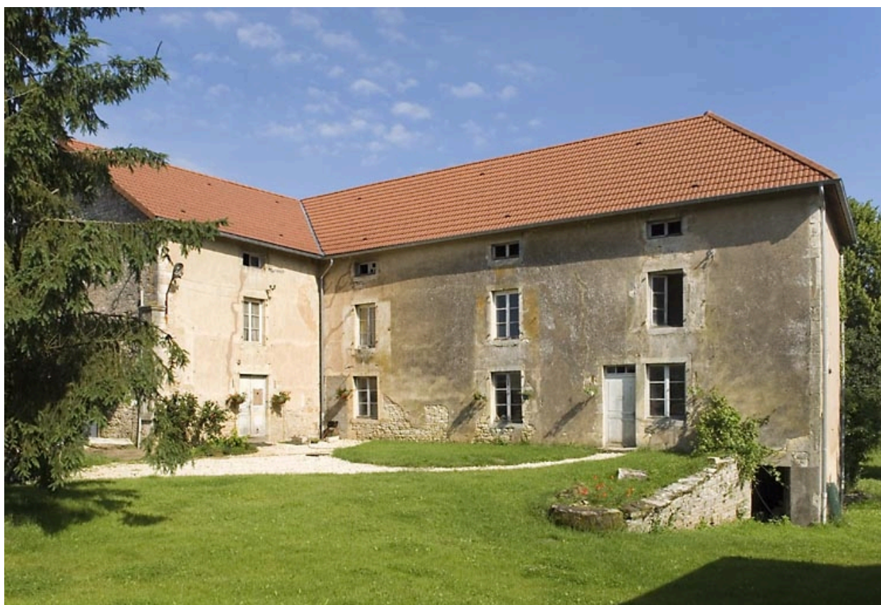
Logement patronal vu de trois quarts.
