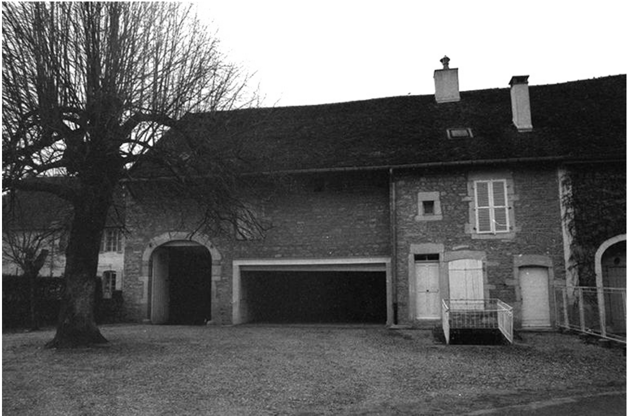
Maison de vigneron : façade antérieure.
