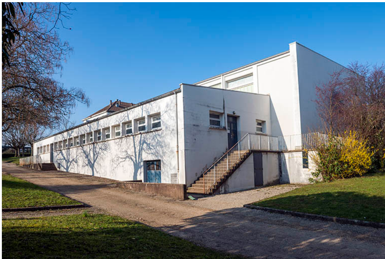
Façade nord-est du gymnase de garçons.
