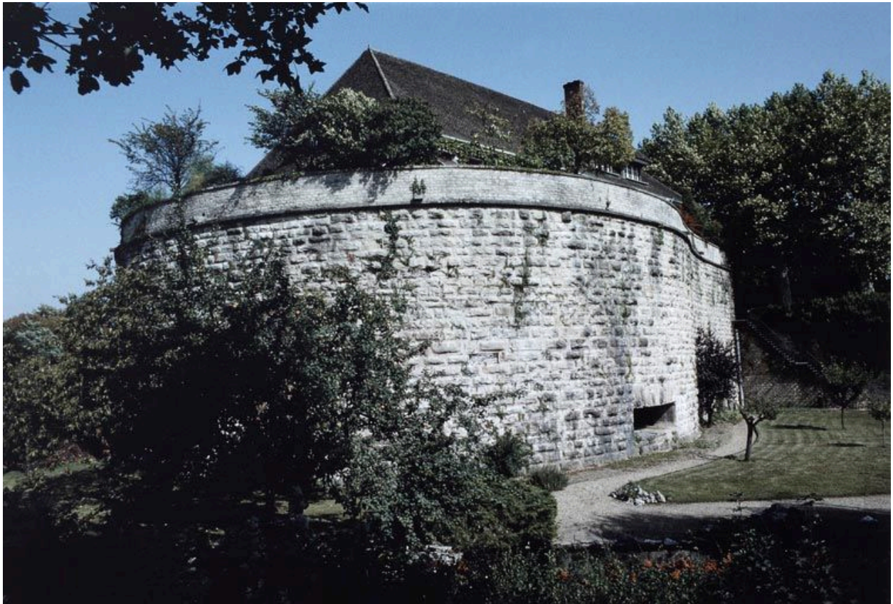
Grosse Tour (improprement appelée bastion) des Dames Bernardines, ou boulevard de la Bussière, depuis le fossé (1989).
