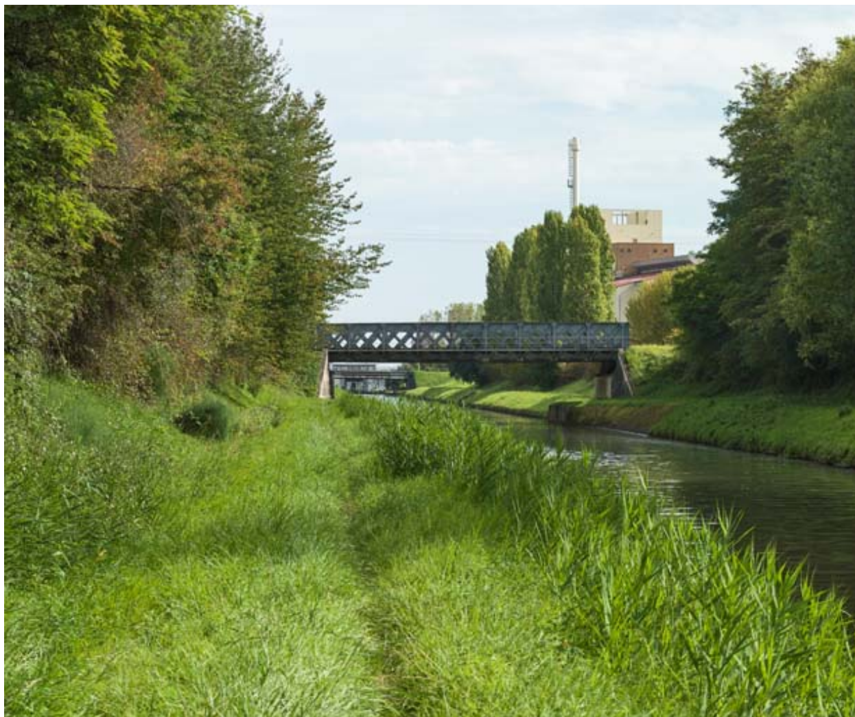
Vue d'ensemble du pont.
